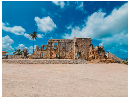
Foto 01 – Vista frontal da Ruína da Igreja de São Bento Distrito de São Bento, Maragogi - AL
